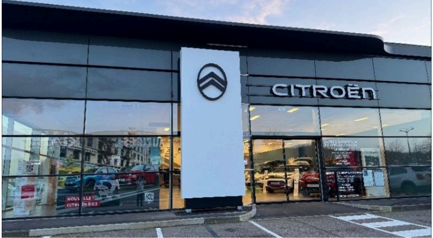
L'entrée du showroom Citroën à Thionville.
